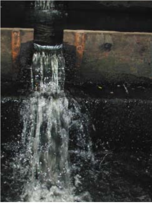
Larsen Creek Baffles 5/28/03
